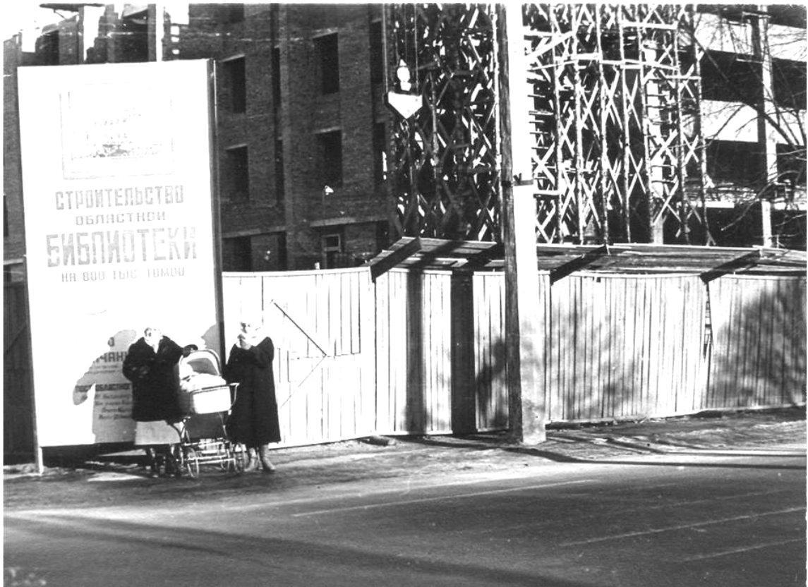
1986–1992 рр. Будівництво нового приміщення Полтавської ОУНБ ім. І. П. Котляревського
