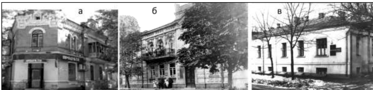
Рис. 3. Будівлі, в яких розміщувалися Полтавський педагогічний інститут та історико-філологічний факультет на початку 1920-х років: а) вул. Лідова, №9/12; б) вул. Стрітенська, №43; в) вул. Шевченка, №20
